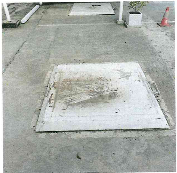
รูปที่ 42 โครงการจัดให้มีถังเก็บน้ำสำรอง รวม 1,206 ลบ.ม. แบ่งเป็น ถังเก็บน้ำใต้ดินติดตั้งไว้บริเวณที่จอดรถด้านหลังอาคารโรงพยาบาล 1 ถัง และถังเก็บน้ำบนดาดฟ้า 2 ถัง
