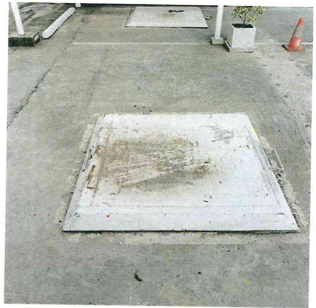
รูปที่ 47 โครงการออกแบบฝาดัง (ช่องคนเข้า) เพื่อให้เจ้าหน้าที่สามารถเข้าไปตรวจสอบ ซ่อมบำรุง จำนวน 2 ฝาดัง โดยตำแหน่งฝาดังอยู่บริเวณพื้นที่จอดรถ
