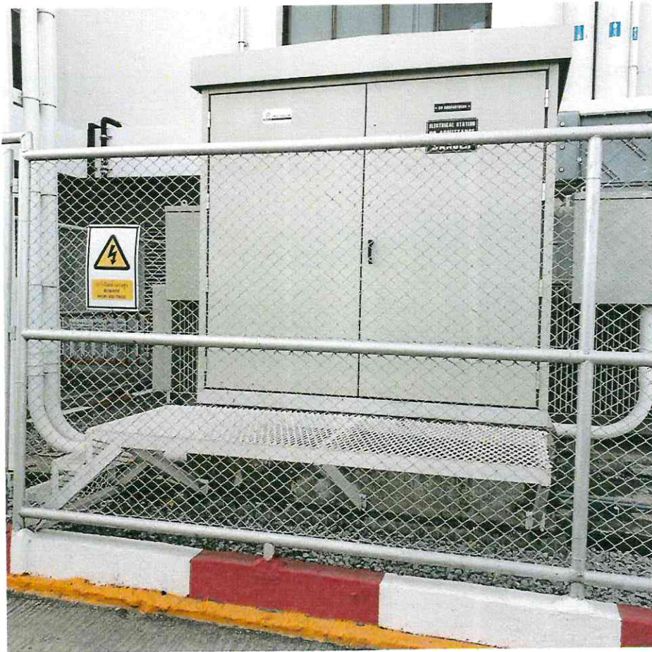
รูปที่ 34 โครงการมีการติดตั้งหม้อแปลงไฟฟ้า ชนิด Oil Immersed Type ขนาด 2,000 KVA จำนวน 2 ชุด ไว้บริเวณด้านหลังอาคารโรงพยาบาล
