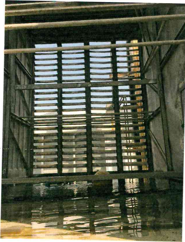
รูปที่ 101 โครงการจัดให้มีผนังล้อมรอบด้านข้างเหนืออ่างรองรับน้ำในหอผึ่งเย็น เพื่อลดการฟุ้งกระจายของละอองไอน้ำ
