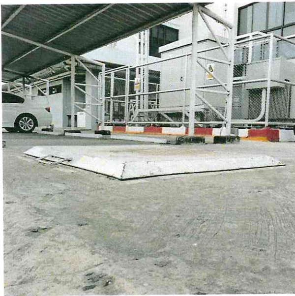
รูปที่ 42 โครงการจัดให้มีถังเก็บน้ำสำรอง รวม 1,206 ลบ.ม. แบ่งเป็น ถังเก็บน้ำใต้ดินติดตั้งไว้บริเวณที่จอดรถด้านหลังอาคารโรงพยาบาล 1 ถัง และถังเก็บน้ำบนดาดฟ้า 2 ถัง
