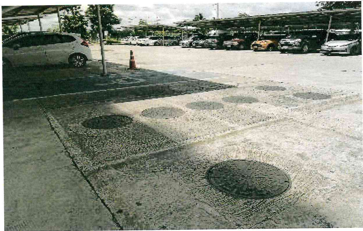
รูปที่ 74 โครงการจัดให้มีระบบบำบัดน้ำเสียชนิดเติมอากาศแบบมีตัวกลางยัดเกาะ รองรับน้ำเสียได้ 160 ลบ.ม./วัน จำนวน 1 ชุด ติดตั้งไว้ด้านหลังอาคารโรงพยาบาล
